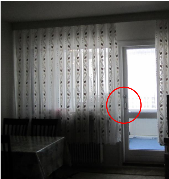
Hvidovre Enghavevej 10, 1. th, skydedør med skålgreb og indvendigt bøjlegreb.
