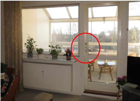
Hvidovre Enghavevej 470, 3. th skydedør med skålgreb og indvendigt bøjlegreb.
