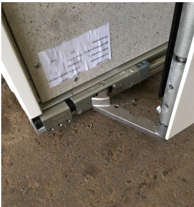
Foto af stopklodsen (med de 3 umbraco-skruer)
