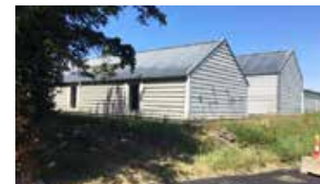
Mod nord ligger to haller med faciliteter til vandværket.
