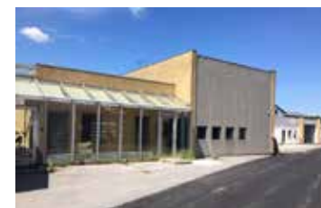
Bebyggelsen nord for bungaloven ønskes anvendt til hjælpemiddeldepot og udbygget med en ny lagerhal til opbevaring af hjælpemidler.
