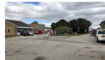
Kig ind i området fra Bibliotekvej. Her ses, hvordan vejen i området deler sig i to dele, med vandværksbygningerne til højre og de nu tomme administrations-, lager- og garagebygninger til venstre. Bag træerne i midten ligger to nyere bygninger/haller som hører til vandværket.
