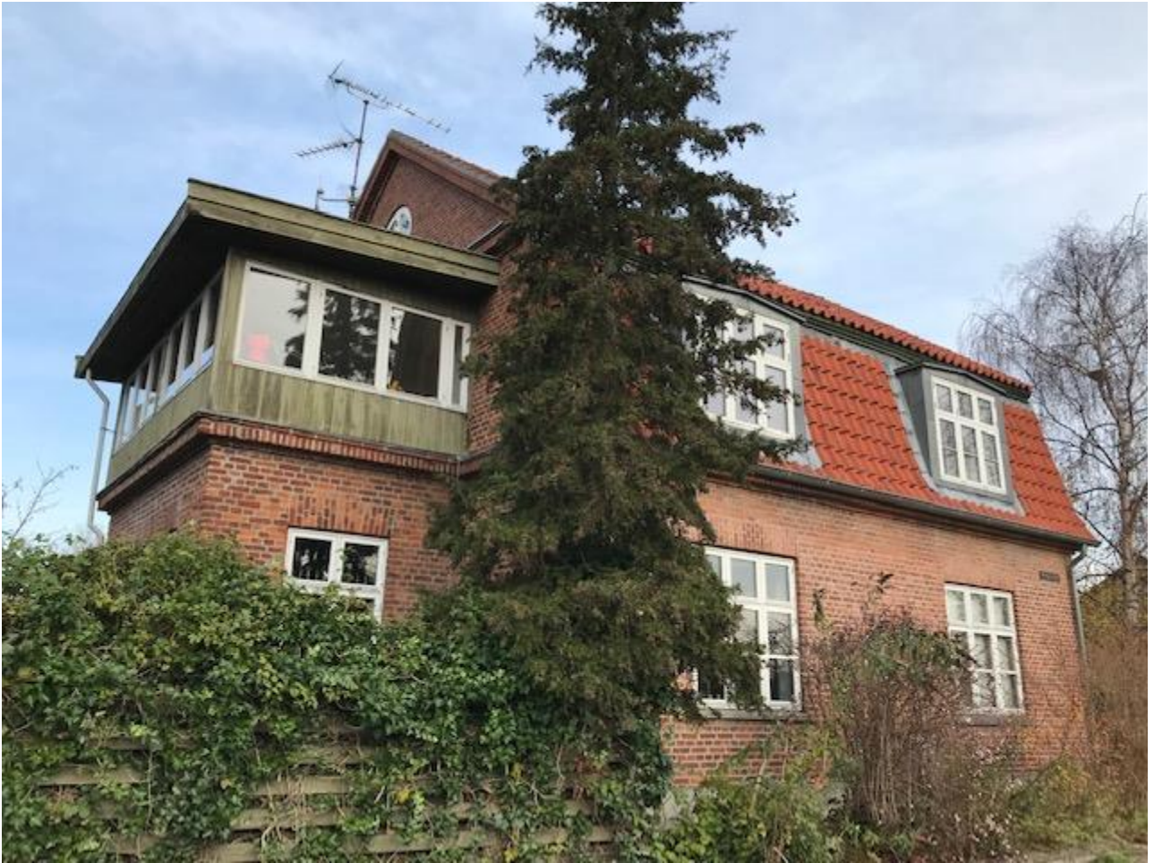
Risbjergvej 5 – lukket altan opført i 1988.
