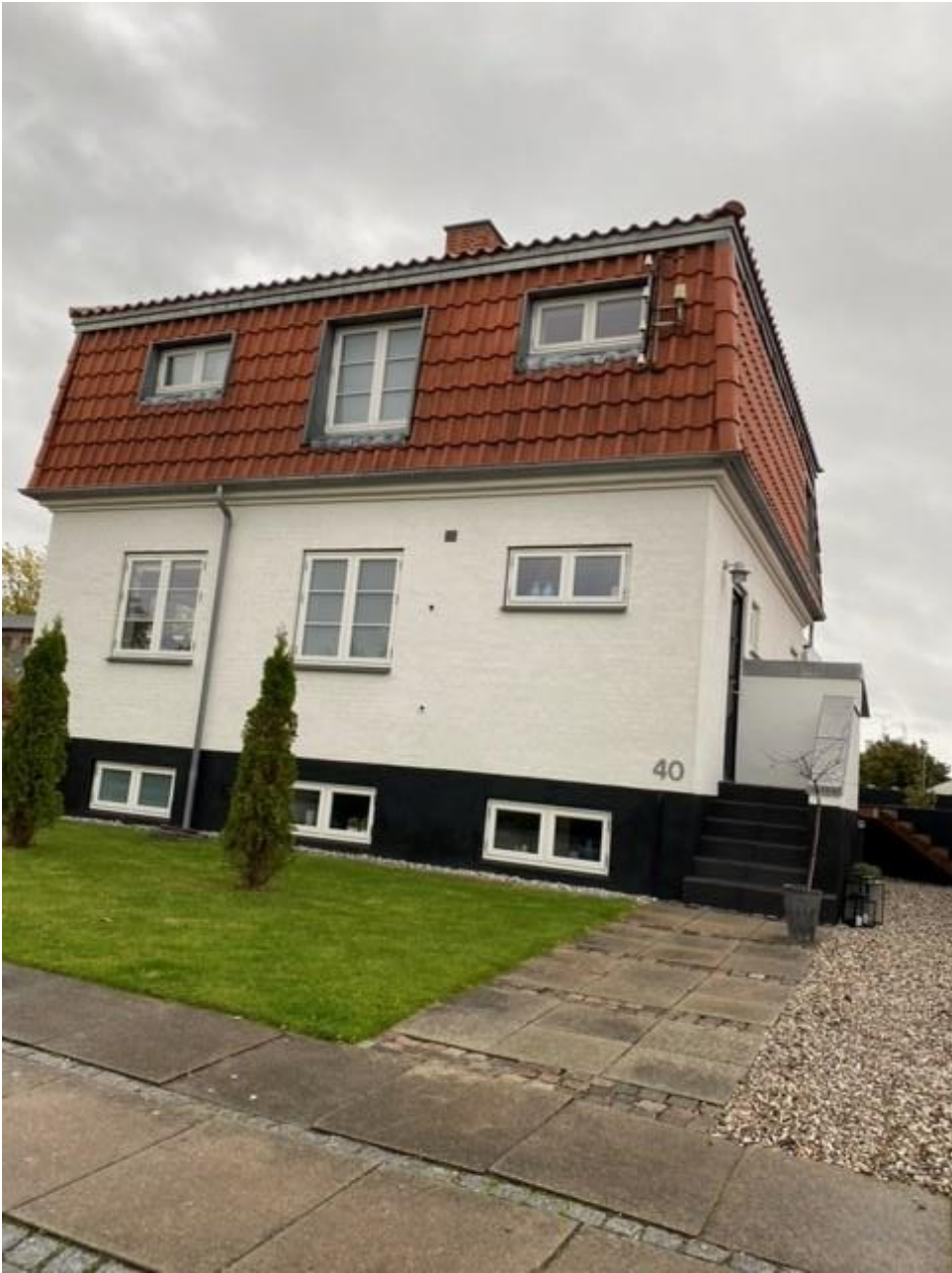
Strøbyvej 40 – opført i 1934
