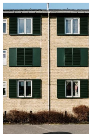
Figur 32. Støjdæmpende multifunktionsvindue (billederne til venstre og i midten). Støjen dæmpes på vejen gennem åbningen for neden (udendørs) til åbningen for oven (indendørs). Til højre er vist en lydskodde, som er monteret foran et eksisterende vindue. Den dæmper støjen, men giver også adgang for frisk luft. Den kan desuden mørkelægge et rum, hvis det ønskes.
