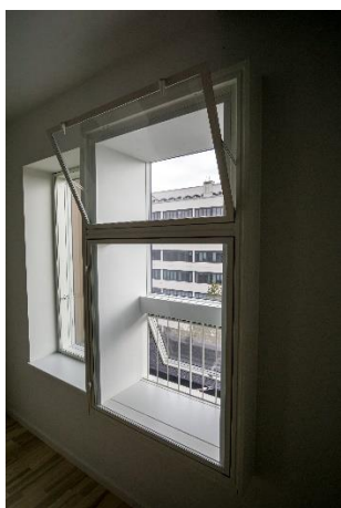
Figur 32. Støjdæmpende multifunktionsvindue (billederne til venstre og i midten). Støjen dæmpes på vejen gennem åbningen for neden (udendørs) til åbningen for oven (indendørs). Til højre er vist en lydskodde, som er monteret foran et eksisterende vindue. Den dæmper støjen, men giver også adgang for frisk luft. Den kan desuden mørkelægge et rum, hvis det ønskes.
