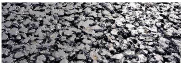
Figur 24. Nærbillede af et nyt og mindre støjende slidlag (teknisk betegnelse: SMA-8). Både den meget jævne og åbne overfladestruktur ses tydeligt. En traditionel belægning (f.eks. SMA-11) har en grovere og mere ujævn struktur.
