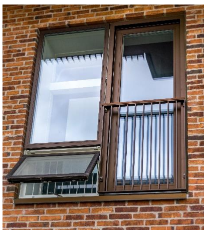
Figur 32. Støjdæmpende multifunktionsvindue (billederne til venstre og i midten). Støjen dæmpes på vejen gennem åbningen for neden (udendørs) til åbningen for oven (indendørs). Til højre er vist en lydskodde, som er monteret foran et eksisterende vindue. Den dæmper støjen, men giver også adgang for frisk luft. Den kan desuden mørkelægge et rum, hvis det ønskes.
