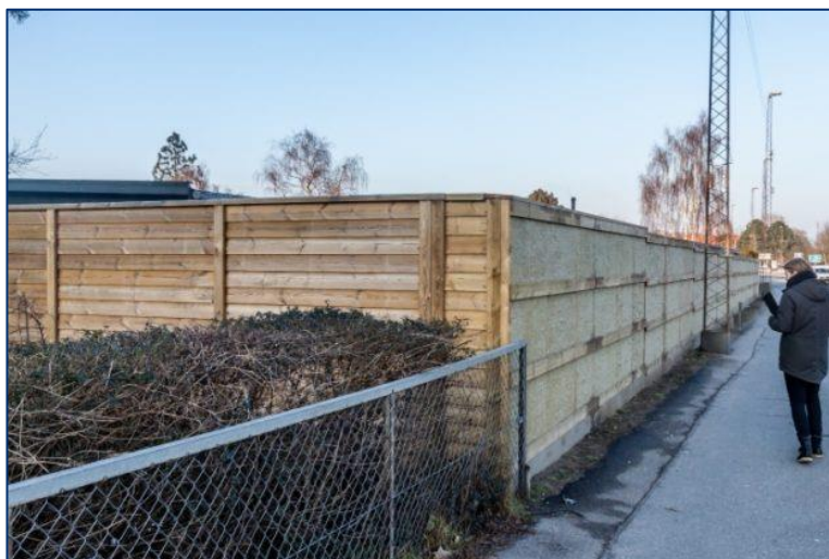
Figur 36. Her har grundejeren bygget sit eget støjhegn og brugt mineraluld på siden mod vejen. Hegnet har formentlig en god støjdempende virkning fordi det er tæt, har en god højde og går op i skel vinkelret på vejen. Mineralulden har ingen betydning for hegnets støjdempende virkning hos grundejeren.
