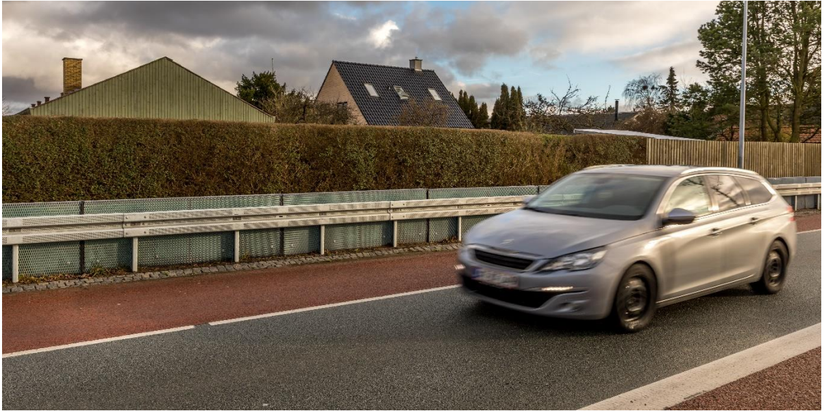
Figur 27. Autoværn, der er udformet som en lav støjskærm. Selvom skærmen er lav, kan der være en støjdæmpende virkning, fordi den står meget tæt på støjkilden (Vejlegårdsvej, Vallensbæk Kommune).
